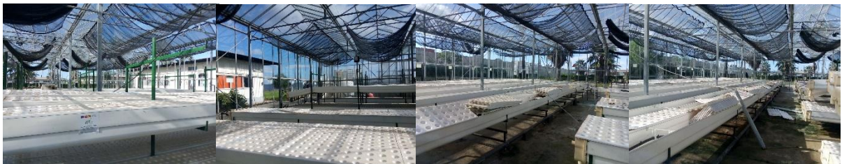
Figure 3: Etat réel du compartiment A
